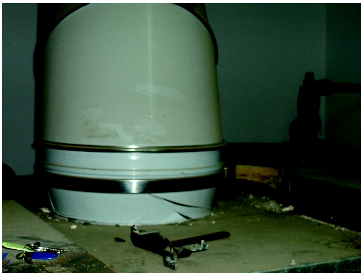
Ilustración 31: Salida de humos de Caldera
