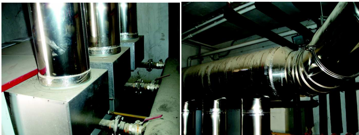
Ilustración 58: Salida de humos de la caldera de tres cuerpos
