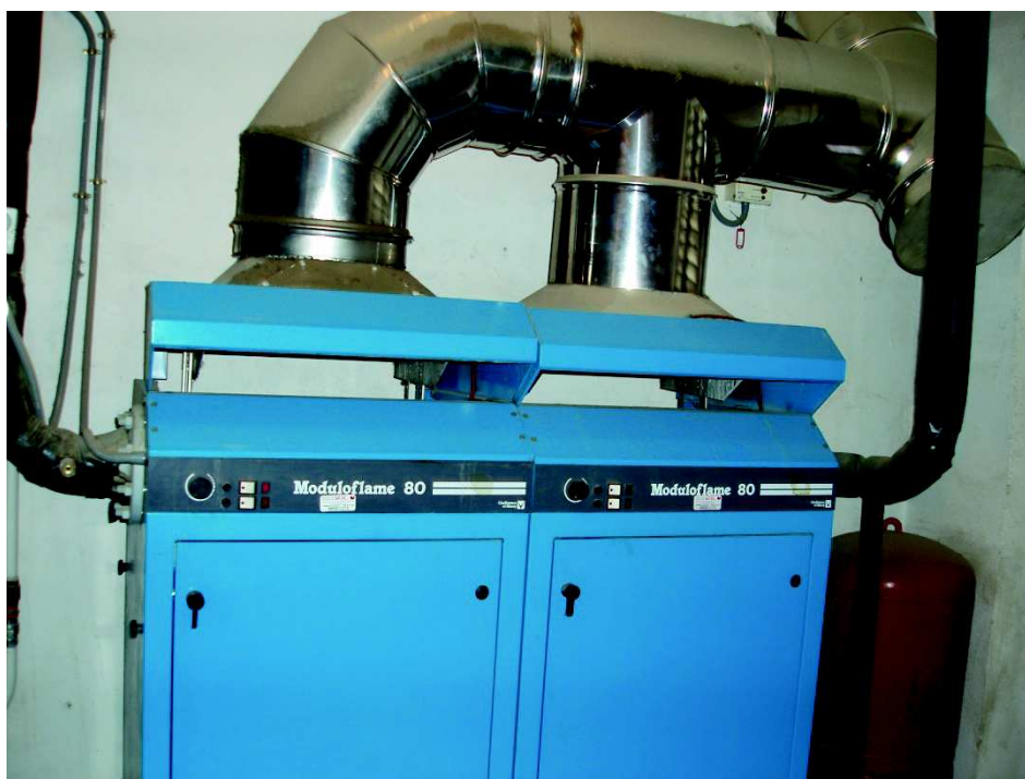
Ilustración 53: Salida de humos de Caldera
