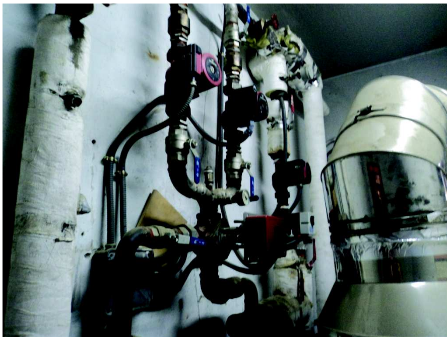
Ilustración 18: Salida de humos de Caldera
