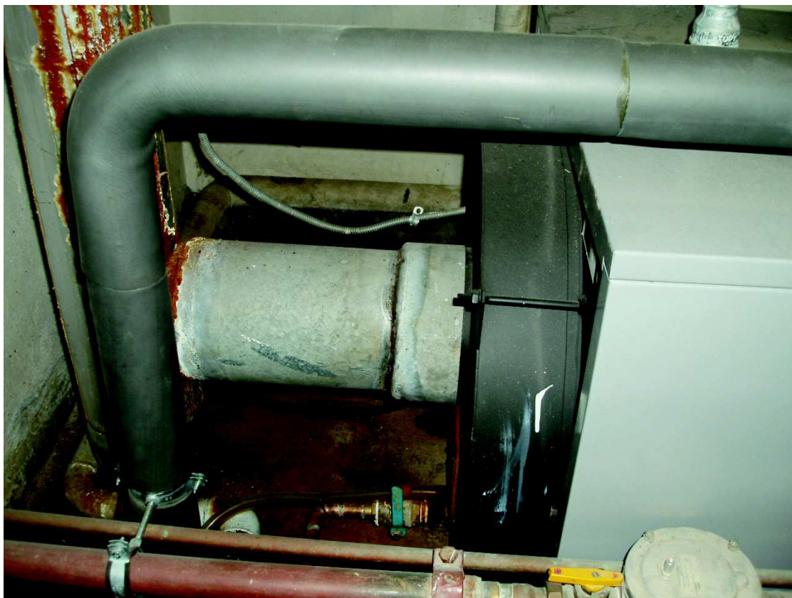
Ilustración 51: Salida de humos de Caldera
