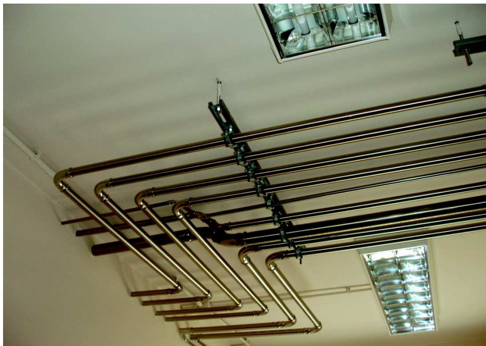
Ilustración 15: conducción con mal aislamiento.
